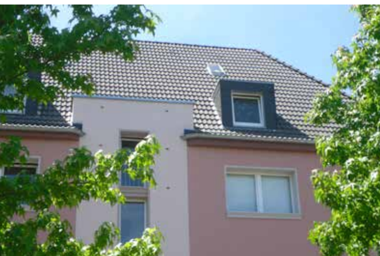
Abbildung 140: Die ersten neu installierten Mauerseglerkästen an einem Gebäude im Essener Südostviertel (Foto: Franco Cassese)
