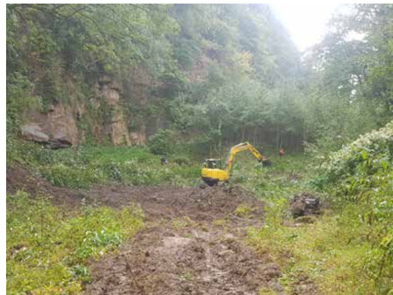
Abbildung 139: Rodungsarbeiten im Steinbruch Laupendahler Straße
