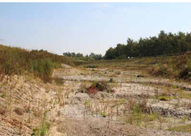
Abbildung 106: Blick in die noch nicht geflutete Aue des Lämpkes Mühlenbaches
