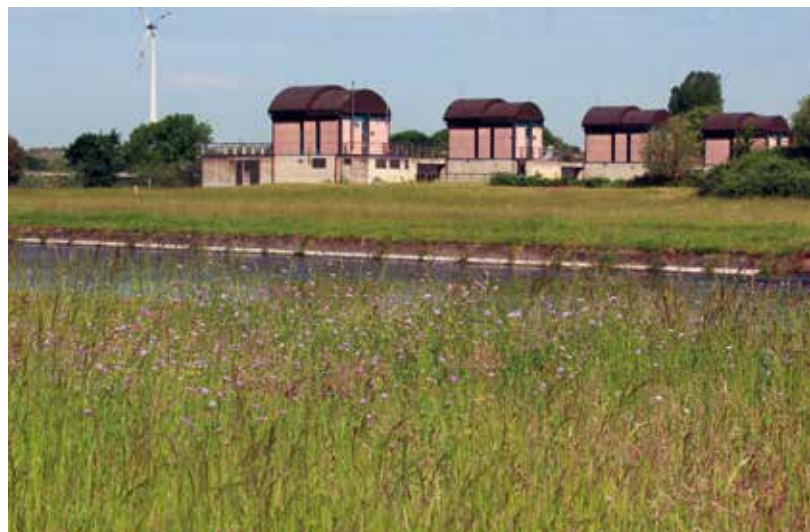
Abbildung 20: Glatthaferwiese auf dem Gelände der Trinkwassergewinnung in Mülheim an der Ruhr.
