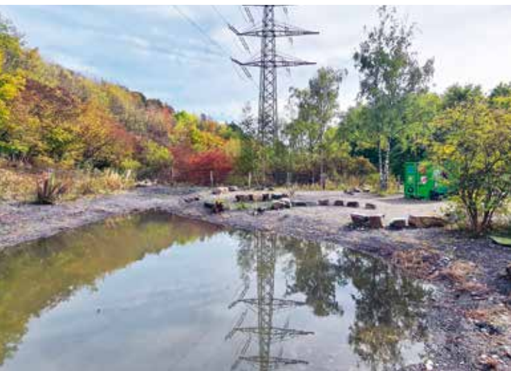
Abbildung 44: Abgeschobene Fläche auf der Halde Eickwinkel für das Projekt LELINA. Im Vordergrund ist das neu angelegte Gewässer, im Hintergrund die aufgestellten Materialcontainer zu sehen.
