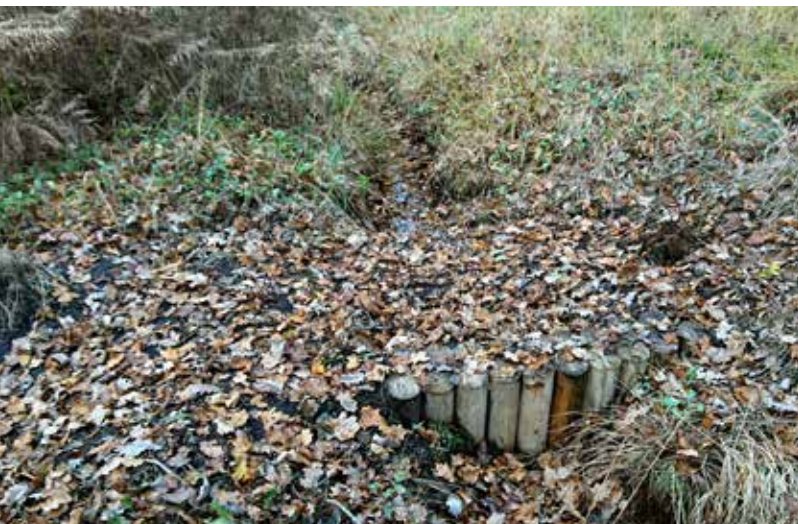
Abbildung 91: Verschluss eines Graben im Holzenbergsbruch
