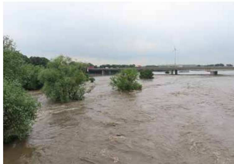
Abbildung 133: Blick von der Raffelbergbrücke auf die A 40 in der fast vollständig überfluteten Ruhraue in Mülheim-Styrum (15.06.)
