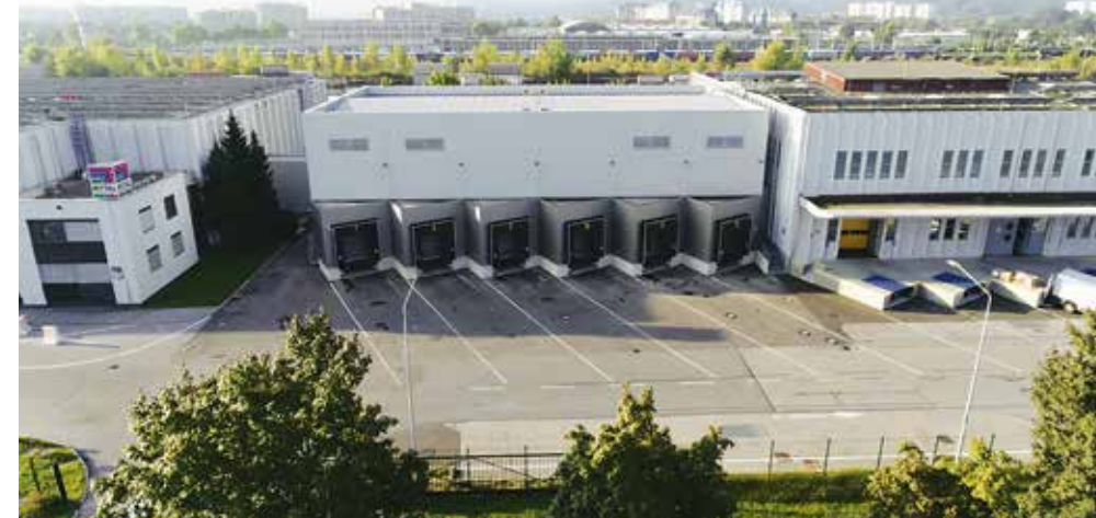
▲ Konsolidacija centralnega skladišča
