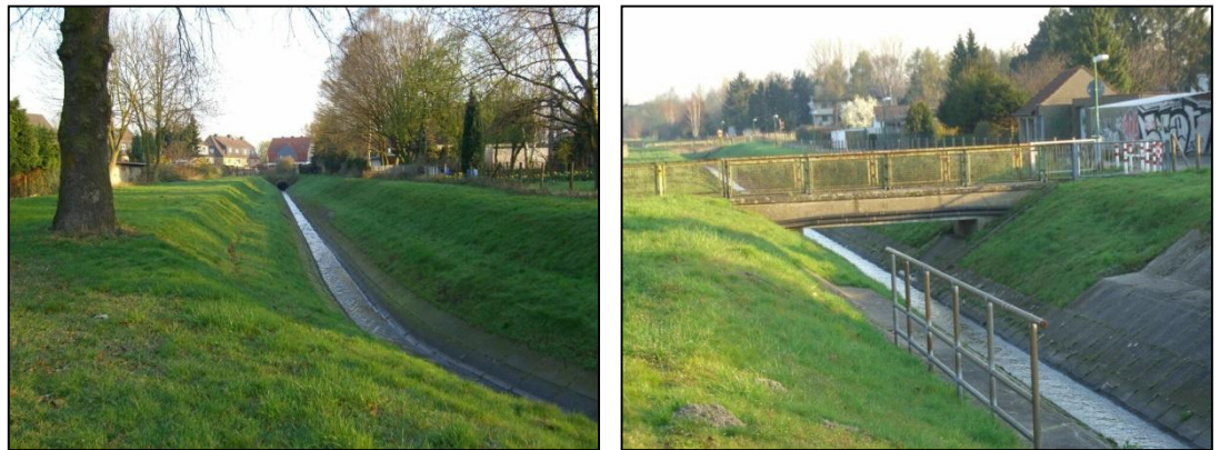
Abb. 6: Dümmerbach oberhalb Zechenstraße und an Wegebrücke
