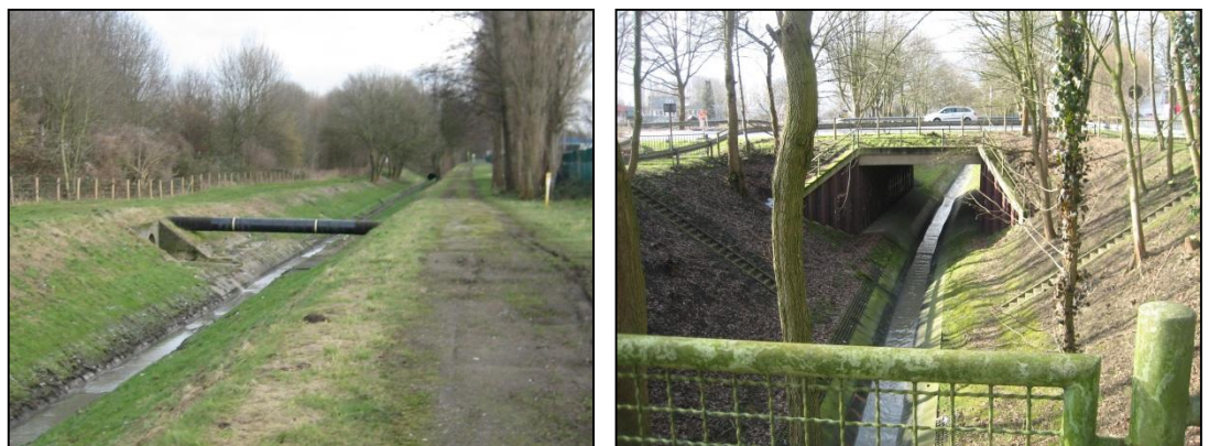
Abb. 3: Westerbach mit Rohrbrücke und Brücke Verbandsstraße
