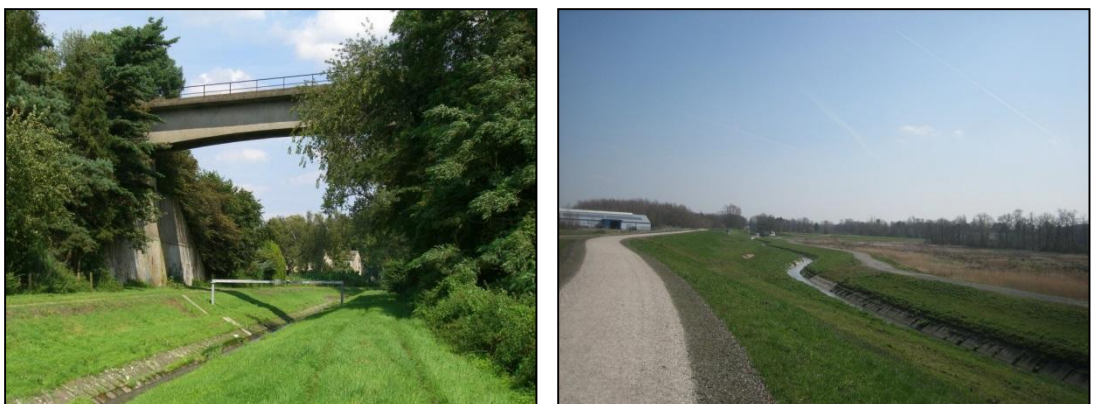
Abb. 5: Dattelner Mühlenbach: Zechenbahnbrücke und Lage im Hochwasserrückhaltebecken
