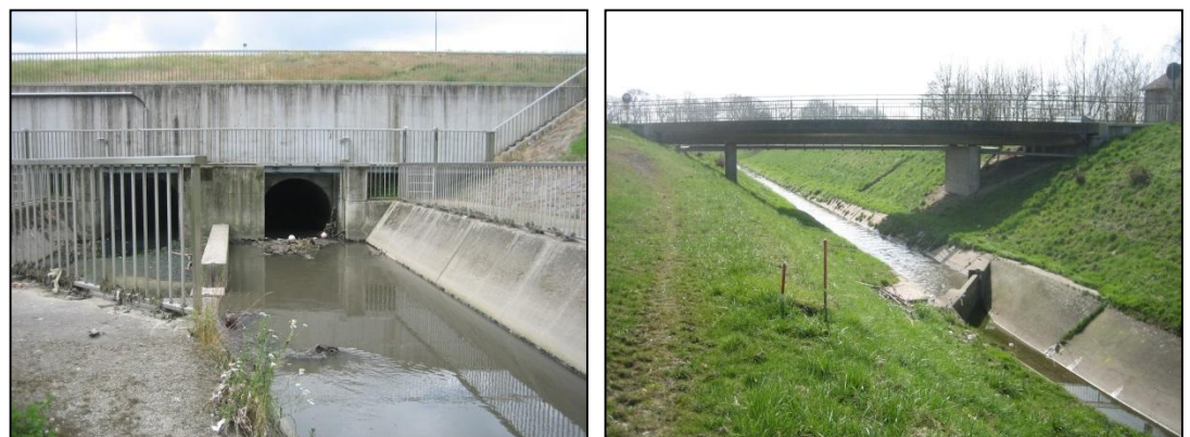
Abb. 8: Dattelner Mühlenbach: Durchlass Wesel-Datteln-Kanal-und Brücke „Zum Ringofen“
