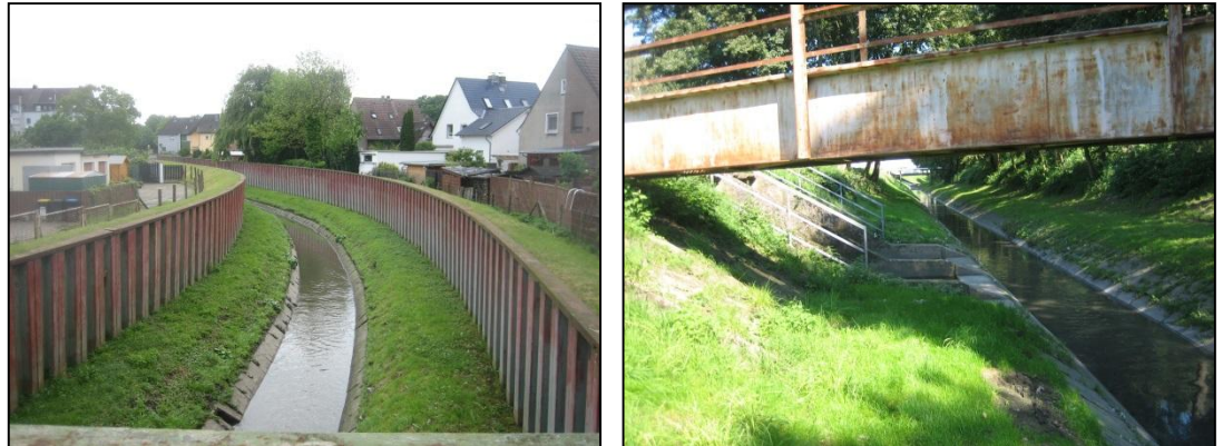
Abb. 7: Dattelner Mühlenbach: Spundwandstrecke und am Pumpwerk Beisenkamp
