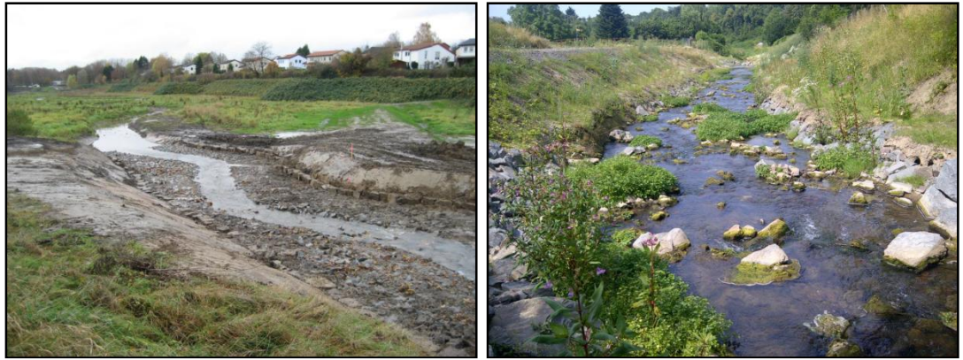
Abb. 17: Beispiele für Sohlgleiten in geschütteter Bauweise, aus (EGLV 2014)
