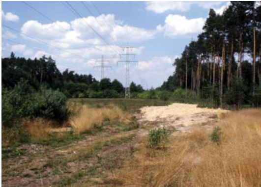
Leitungstrasse zwischen Mischelbach und Röttenbach
