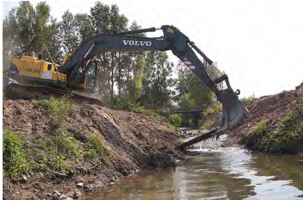
Grenzbefestigungen in einem Nebenfluss der Werra wurden entfernt.
