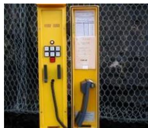
Notruffernsprecher geöffnet
