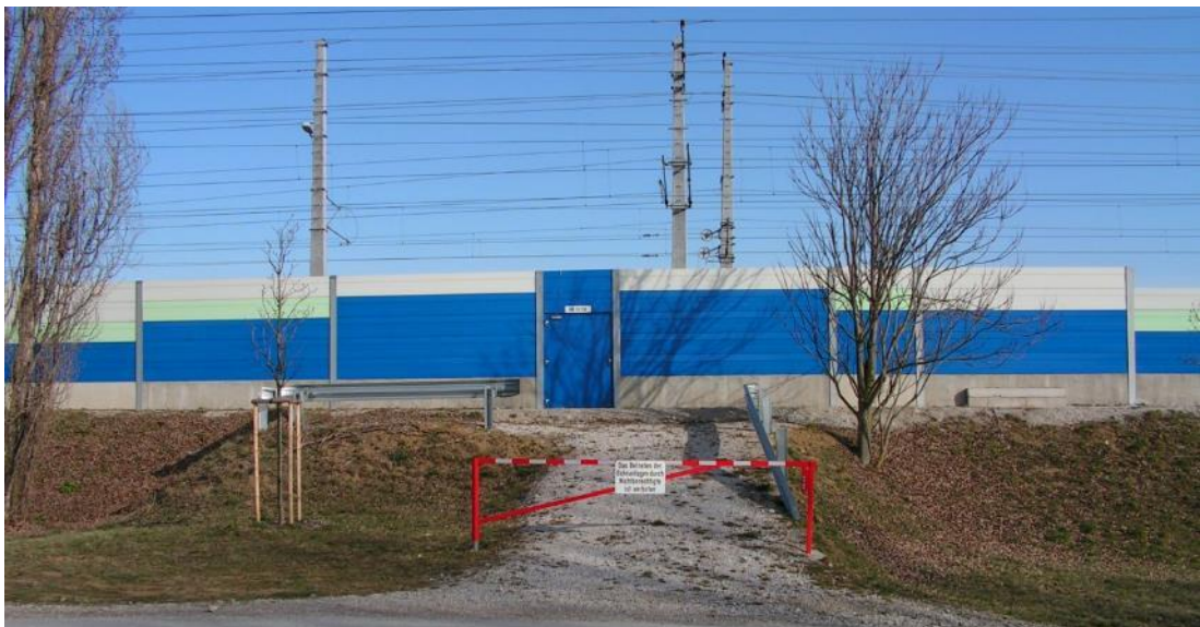
Abbildung 43 – Lärmschutzwand
