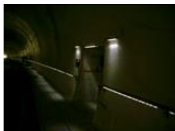
Handlauf mit integrierter Orientierungsbeleuchtung
