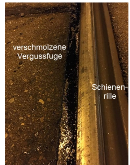
Abb. 03-3: Nach dem Schweißen verschmolzene Vergussfuge
