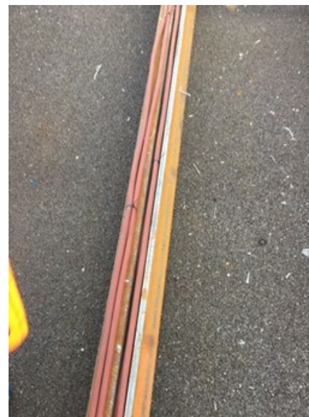
Abb. 20-2: verlegte Induktionsschleifen in einer Flachrille zum Vorwärmen
