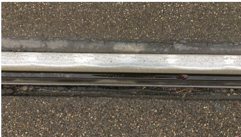
Abb. 14-3: Typische Riffelbildung auf einem Streckengleis
