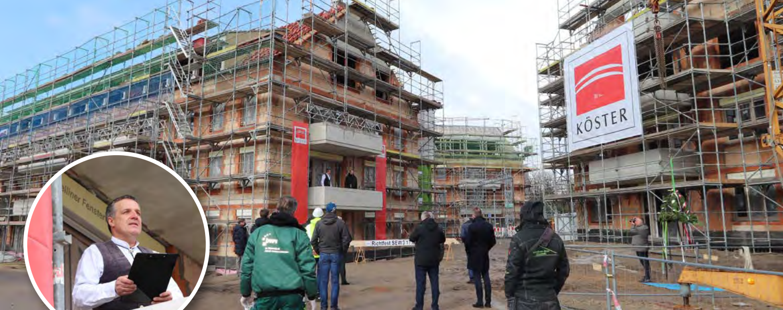
Polier Mike Zebedies bedankt sich in seinem Richtspruch beim Bauherrn und den Kollegen.
