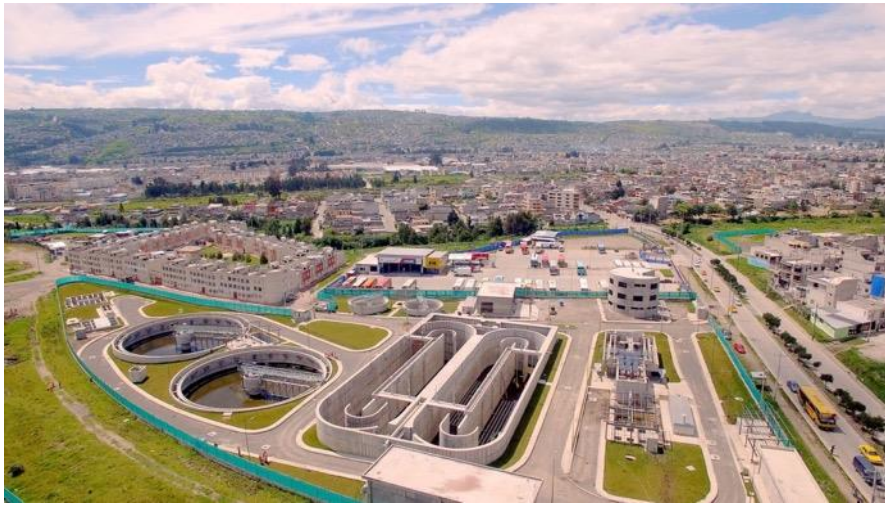
Figura 2 Planta de tratamiento de aguas residuales – Quitumbe
