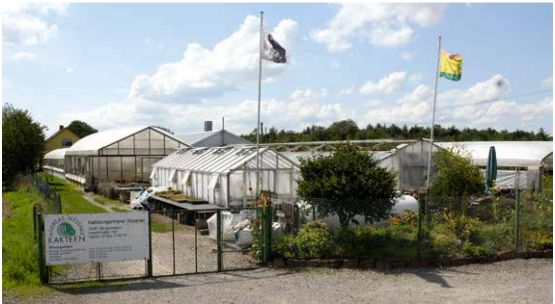
Afb. 3: Het kassencomplex in Muggensturm
