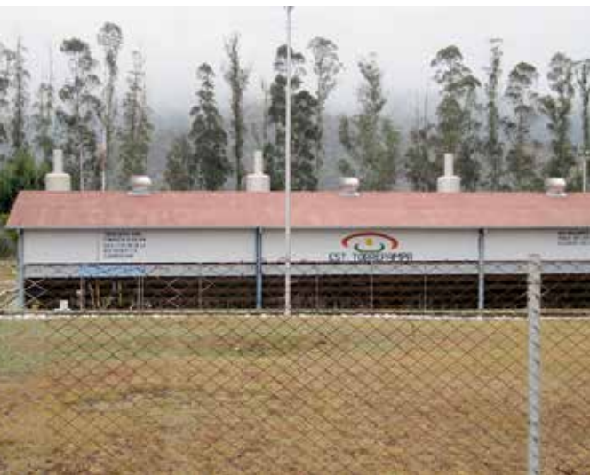
Afb. 1: Pompstation Torre Pampa.
