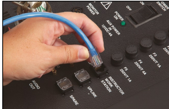
Raccordement du câble Ethernet au bloc A/C
