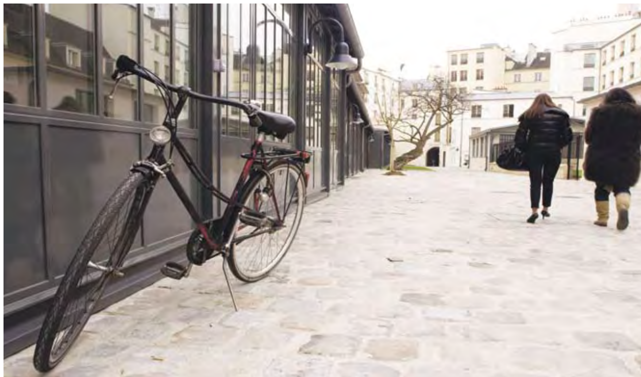
Renovation of the Cour de Venise in the 3 e arrondissement of Paris, © Caisse des Dépôts / Jean-Marc Pettina
