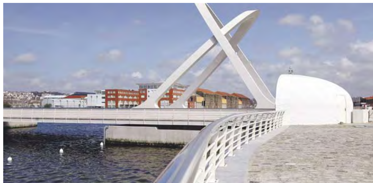
Paul Vatine Bridge – Le Havre, © Caisse des Dépôts / Jean-Marc Pettina
