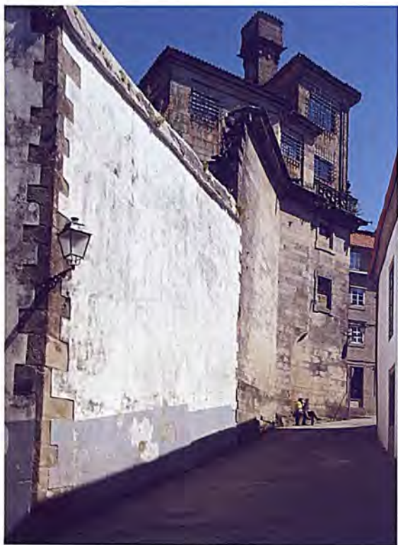
Muro de cierre del lado sur
