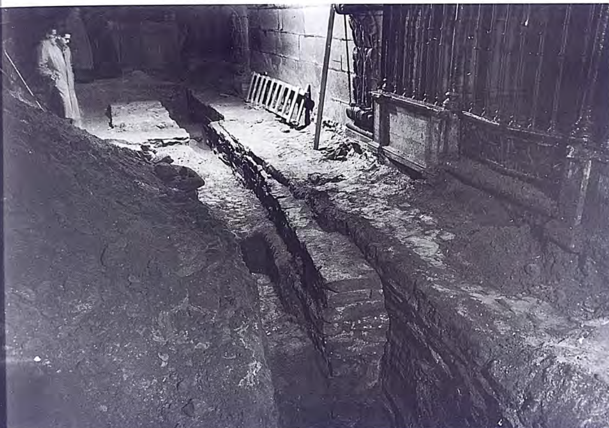
Primitivo muro de cimentación de la girola. Catedral de Santiago de Compostela
