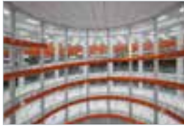
Absturzsicherungen Fall protection
