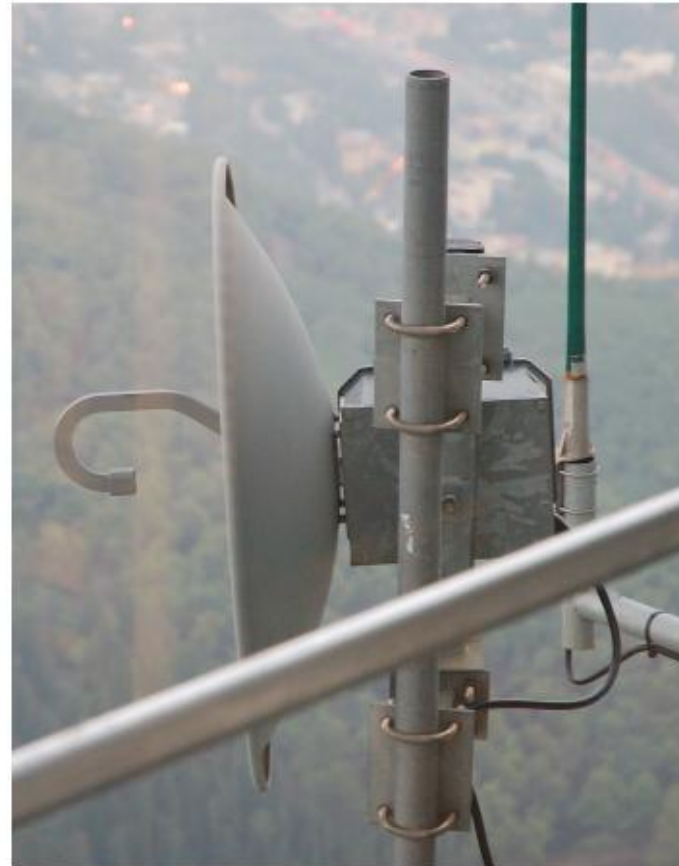
Boca de guía rectangular alimentando un reflector parabólico
