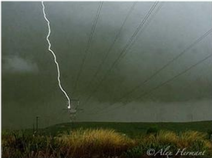
Impacto de rayo en cable de guarda
