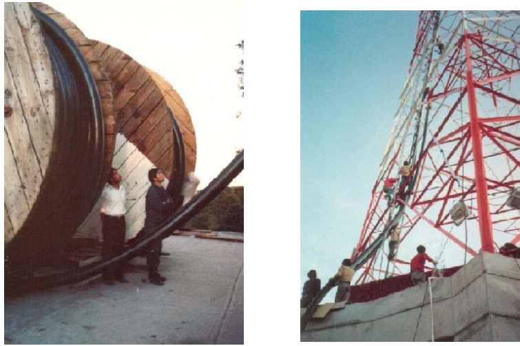
Fig. 9.24. Montaje de una línea de transmisión de 6.5".
