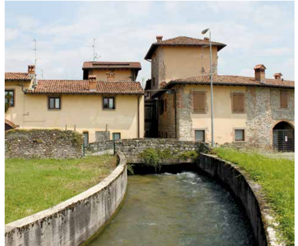
The Morla canal in Via Daste e Spalenga in Bergamo.
