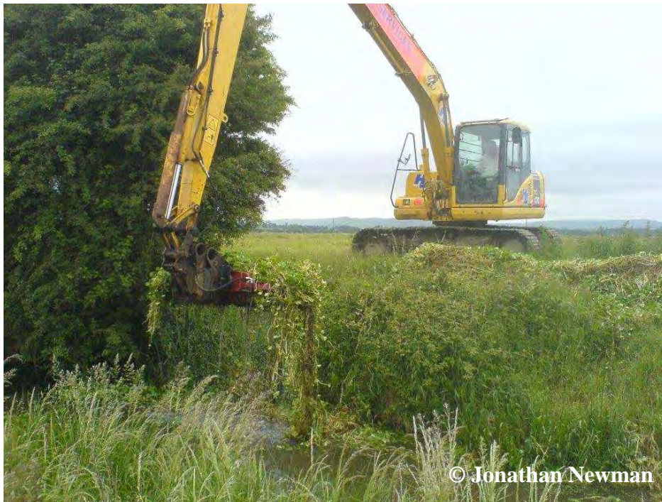
Photo 6 : Chantier de lutte mécanique mené en Grande Bretagne.
