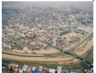
天白川(H12.9名古屋市天白区 浸水状況)
