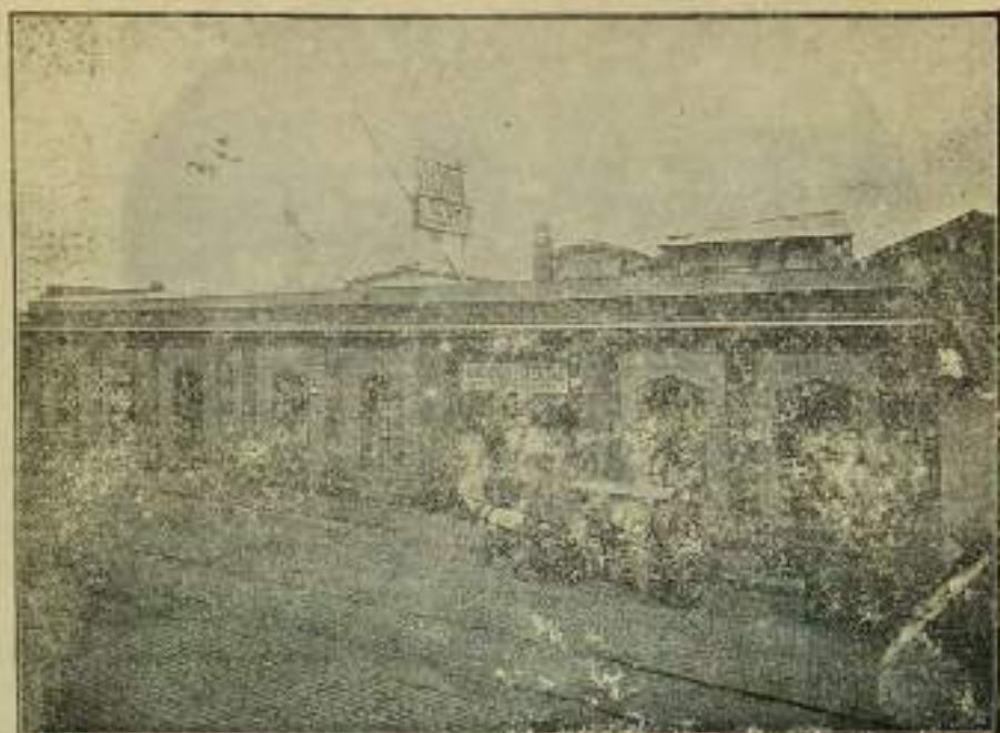
Fachada de la Fundición "Libertad" del señor Fr. Kupfer
