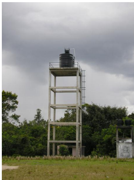
Figura 39. Nuevo tanque elevado en Cacahual (a 30 metros del antiguo) y próximo a inaugurarse
