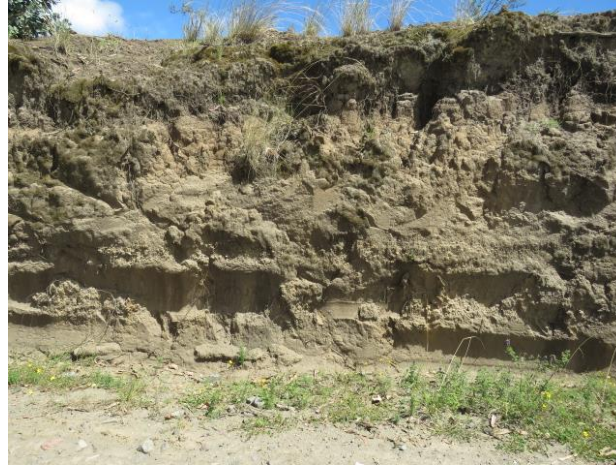
FIGURA 6-39.- VISTA FRONTAL DE LA ESTRATIGRAFÍA QUE SE UBICA AL ESTE DE LA SUBESTACIÓN CAJAS, JUNTO A LA VÍA DE ACCESO A LAS LAGUNAS DEL MOJANDA. SE APRECIA EL INICIO DE LA CANGAHUA A MENOS DE 80 CENTÍMETROS DE LA SUPERFICIE.
