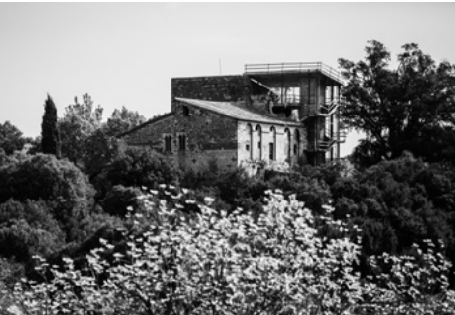
Obres a la torre Desvern de Celrà. Fotografia de Martí Navarro
