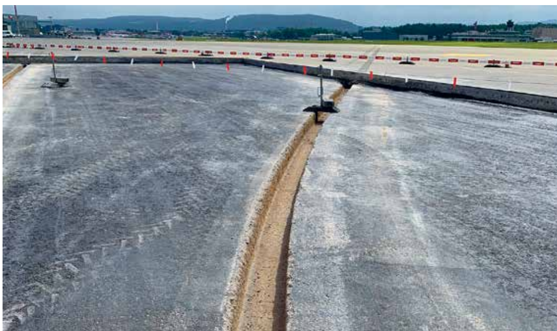
A gurulót irányjelző kivilágításának befogadó árka
