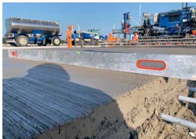
A beton síkfekvésének és állóképességének („zöldszilárdság”) ellenőrzése
