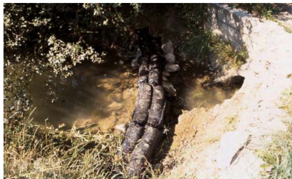
Seuil provisoire sur le contre-canal permettant le maintien de son niveau d'eau (photo : P. Suchet/AVENIR).
