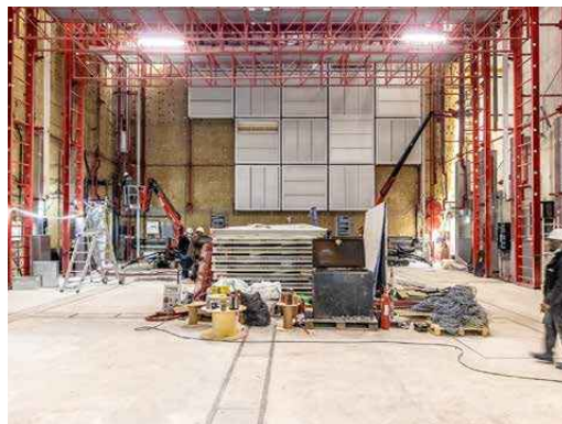
L'Espace de projection en chantier, photo © Philippe Barbosa
