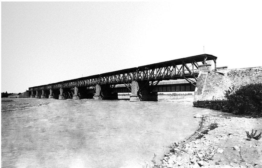
Puente ferroviario y carretero sobre el río Cachapoal. La techumbre de la primera estructura de la fotografía da cuenta que esa fue la pasarela instalada para el tránsito peatonal.
