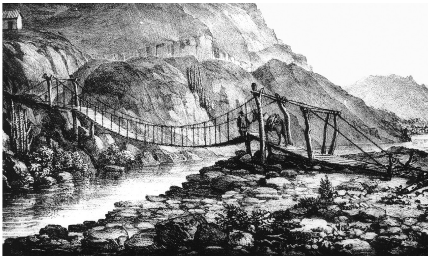
Puente colgante sobre un río en Chile. Estas construcciones se dieron en todo el territorio americano. Fueron útiles para atravesar los cursos de agua cordilleranos y su estrechez da cuenta que solo permitía el tránsito de personas y animales cargados. Dibujo de Mauricio Rugendas, colección Biblioteca Nacional de Chile.
