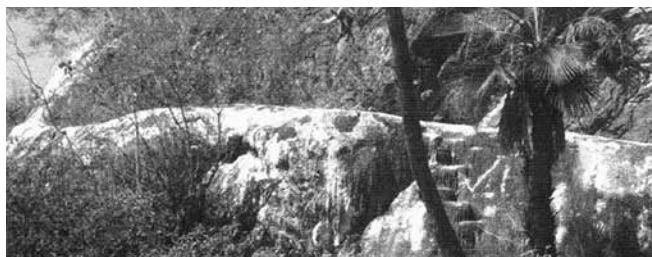
Canal principal que desciende por la ladera sur del brazo oriental (Flores 2003).
