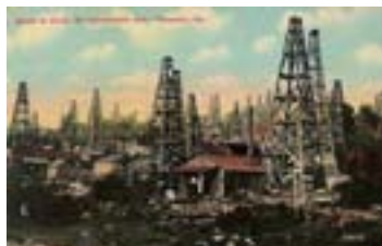
Torres de perforación
