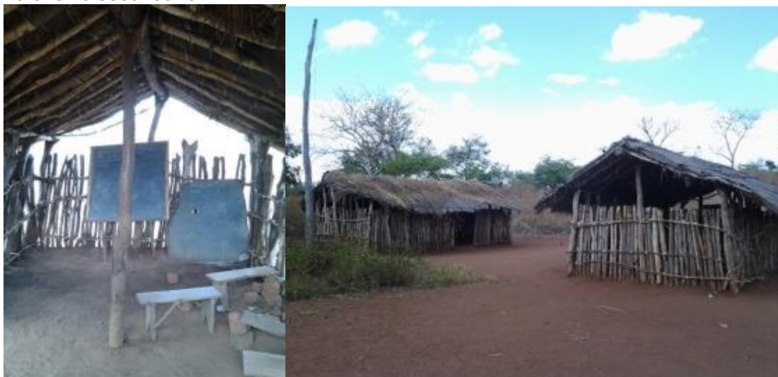
Figura 5-2: Infraestrutura escolar típica da área do projecto (Escola Primária de Matacale)
