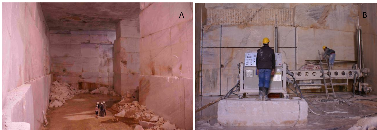
Fig. 11 – A – Cavidade; B – Roçadora e golpes já executados para o avanço em galeria.
