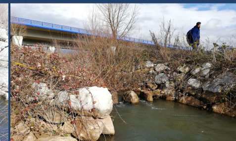
Entrada del paso
