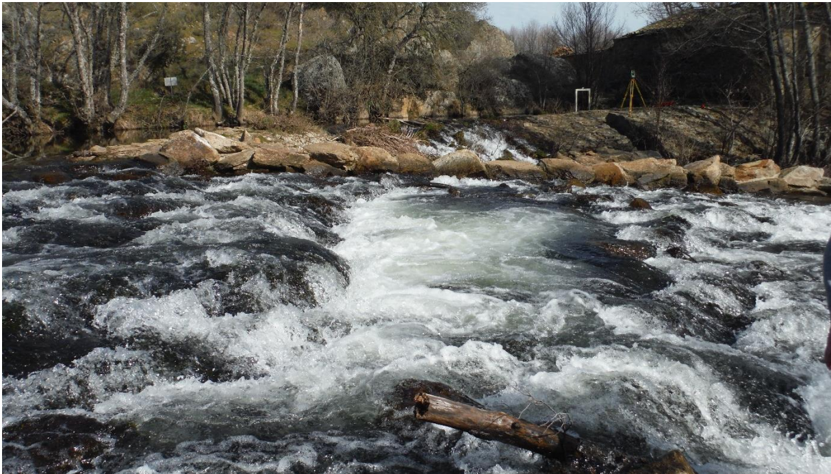
FIGURA 33. RAMPA DE BLOQUES CON ZONAS DE DESCANSO DE MAYOR PROFUNDIDAD Y MENOR PENDIENTE, RÍO NEGRO (PEQUE, ZAMORA).
