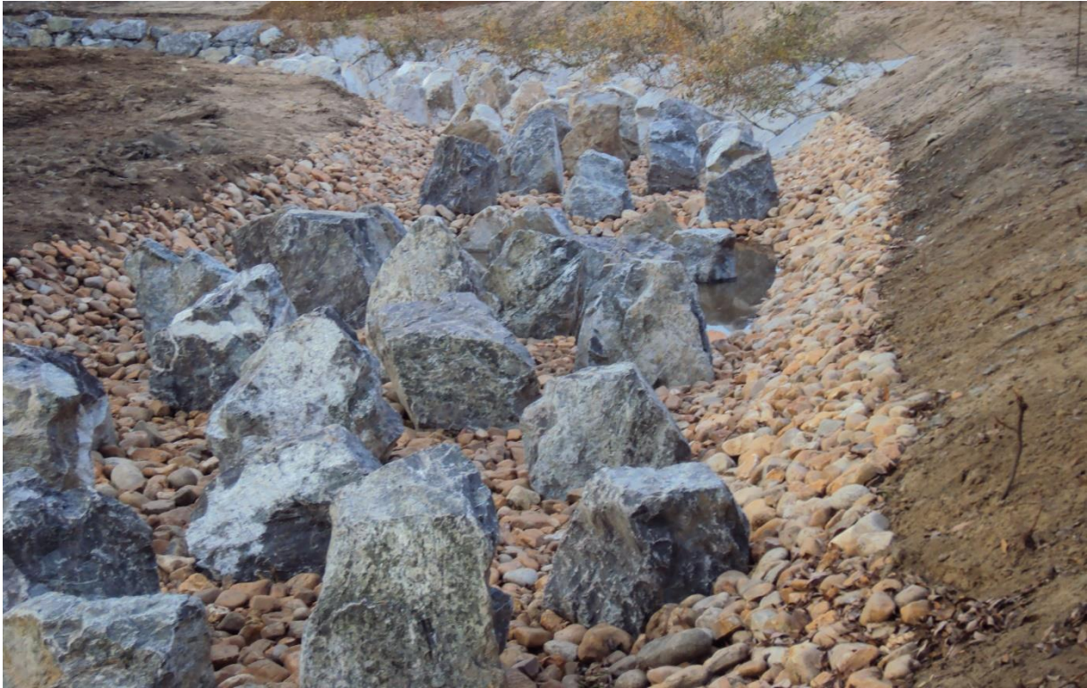
FIGURA 35. FASE DE CONSTRUCCIÓN DE UN RÍO ARTIFICIAL DE BLOQUES, RÍO TORMES (AZUD EL MARÍN, SALAMANCA).
