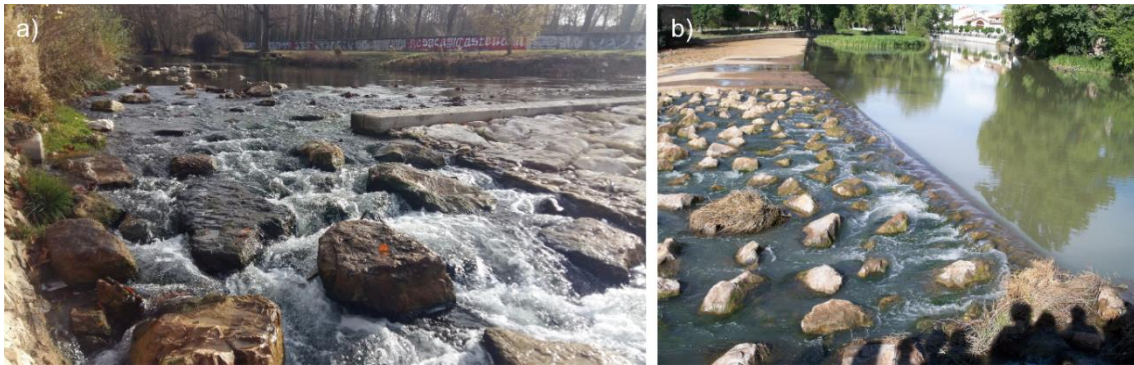
FIGURA 32. EJEMPLOS DE REBAJES EN EL AZUD. a) PASO PARA PECES EN EL AZUD DE LOS TRAMPONES, RÍO ARLANZÓN, BURGOS. b) PASO PARA PECES EN EL “AZUD DEL COLEGIO DE SAN GREGORIO”, RÍO PISUERGA, AGUILAR DE CAMPOO.
