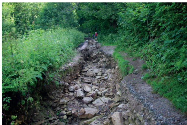
Obr. 3 a Obr. 4 Eroze (vlevo) a sesuv půdy v okolí Horního Maršova (foto autoři).
