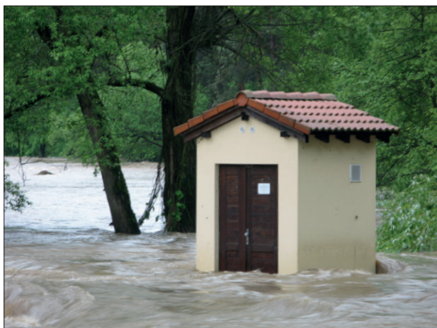
Obr. 5 Limnigrafická stanice ČHMÚ Hrachov – Brzina, 2. 6. 2013 15:00 UTC, Q_{měř} = 64,5 \text{ m}^3 \cdot \text{s}^{-1} , Q_{kulm} = 79,6 \text{ m}^3 \cdot \text{s}^{-1} , měření v profilu u stanice nebylo možné.
