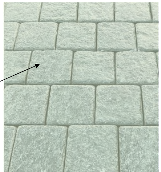
Detail Pflasterung Bauminseln aus Natursteinen
