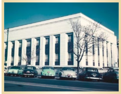
Apuyhdistyksen rakennus Salt Lake Cityssä Utahissa vuonna 1956
