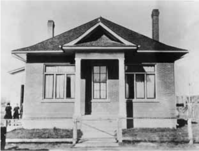
In diesem Gebäude befand sich das erste Seminar der Kirche; es wurde 1912 neben der Granite High School in Salt Lake City eröffnet.
