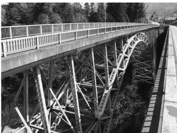
Fig. 6 Arakawa Bridge (Saitama)
