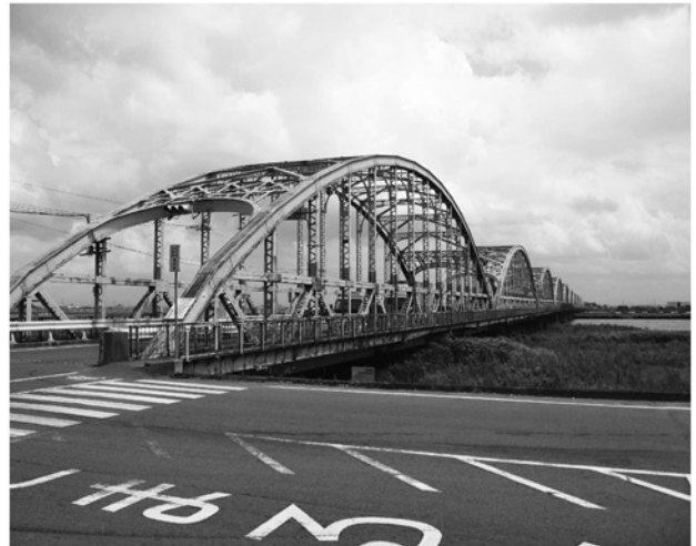
Fig. 3 Ise-Ohashi Bridge (Mie)
