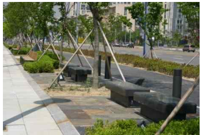
식재대 내부에 가로시설물 통합 설치
