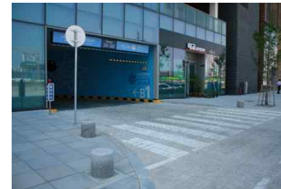
주차장 입구 보도와의 단차를 최소화한 주차장 입구
