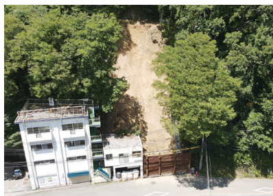
被害拡大を防ぐ処置を施している 鎌田地内の崩落箇所
