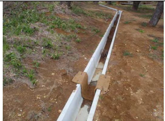
U字溝 (脱出可能対策を施した例) (平成 25 年 5 月 2 日撮影)
