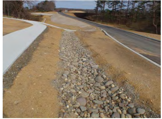
玉石型排水路 (平成 25 年 4 月 16 日撮影)
