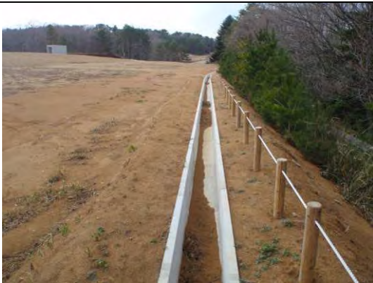
U字溝 (平成 25 年 4 月 16 日撮影)
