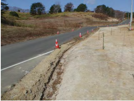
仮設水路 (平成 25 年 4 月 16 日撮影)
