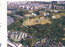
平成17年12月に返還された旧小柴貯油施設
