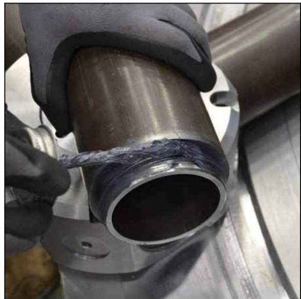
Abbildung 3-12. Aufbringen der Anti-Abnutzungsmasse
