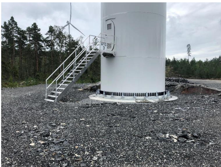
Figur 9 Ett färdigt fundament och ingång till tornet
