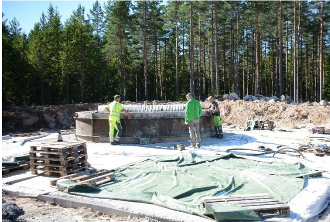
Figur 7 Gravitationsförankrat fundament, Sättravallen vindpark, Kristinehamn
