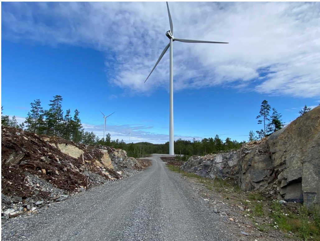
Figur 10 Nyanlagd väg i Marker Vindpark, Norge
