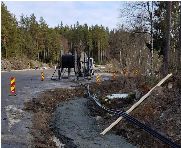
Figur 13 Kabelförläggning, Marker Vindpark, Norge
