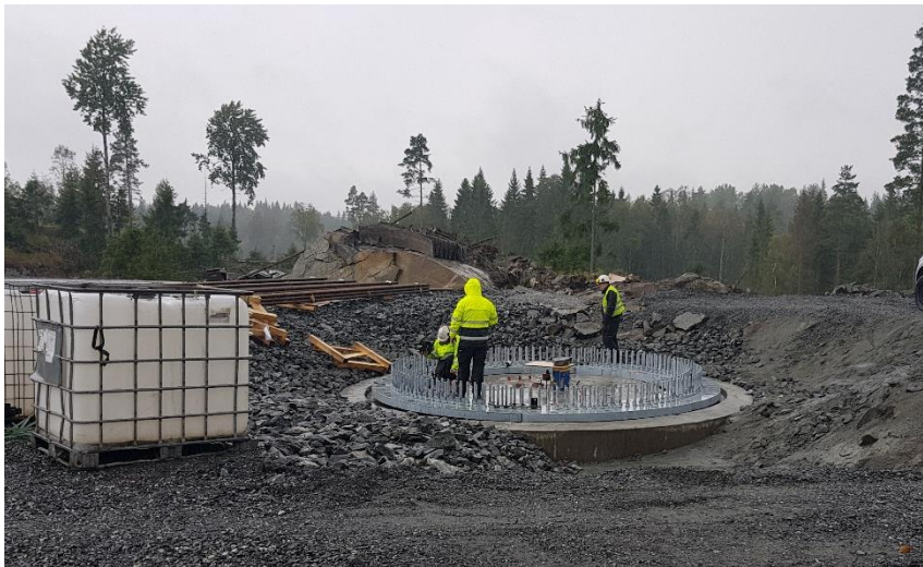
Figur 8 Bergsförankrat fundament, Marker Vindpark, Norge
