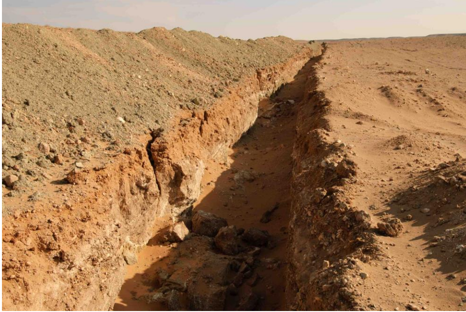
管道施工过程中挖掘的、或是为防止车辆不沿道路行驶而挖掘的壕沟，被视为对野生动物的威胁，可能对野生动物活动构成障碍。©WCS/K.Murphy
