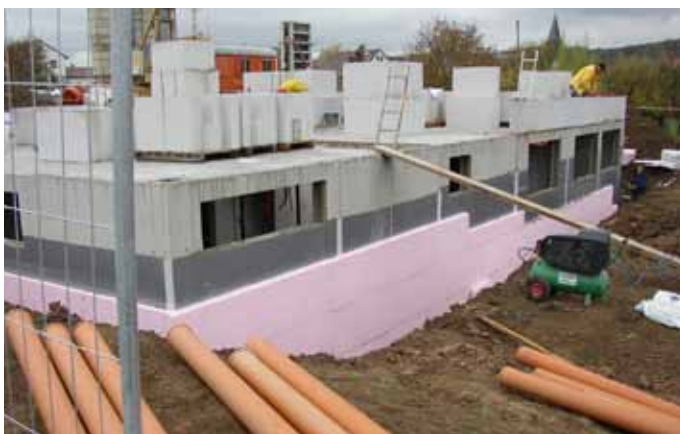
SilverSeal bereits im Fertigteilwerk mit Betonschalung.
