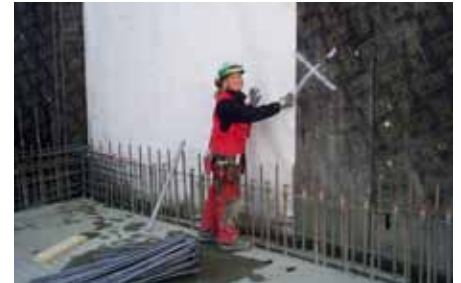
Oben: SilverSeal im Einsatz im Tunnelbau. Unten: Silverseal vorgängig auf Schalung montiert.
