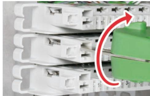
Die LSA-HD®-Leisten können bei Bedarf von der HD-Montagewanne gelöst werden (Abb. 6). Hierzu ist die herausklappbare Klinge des LSA-Anlegewerkzeugs in die Öffnung über dem kreuzförmigen Ausschnitt zu stecken. Durch Drehen des Werkzeuges und gleichzeitiges Ziehen an der Leiste lässt sich die Rastverbindung lösen. Die Leiste ist auf der linken und auf der rechten Seite zu entriegeln.
