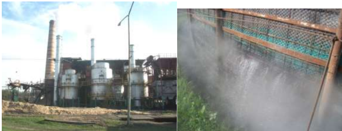
Zona de calderas, filtros tipo scrubber y sistema de recuperación de agua.
