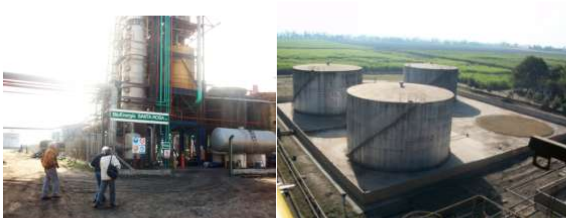
Zona de la destilería de alcohol BIOENERGIA SANTA ROSA S.A.
