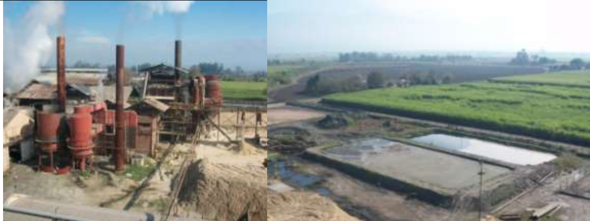
Zona de calderas y piletas de sedimentación para agua con cenizas. Cachaza dispuesta al fondo
